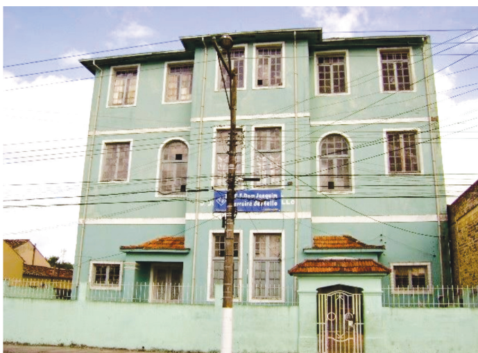
Figura 1: Antigo prédio da E.E.E.F. Dom Joaquim Ferreira de Mello
